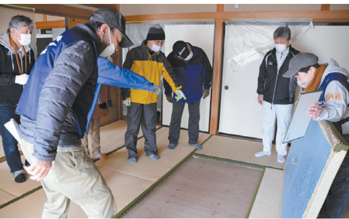
和室の畳上げ作業=写真はいずれも出雲市松寄下町の同市総合ボランティアセンター
